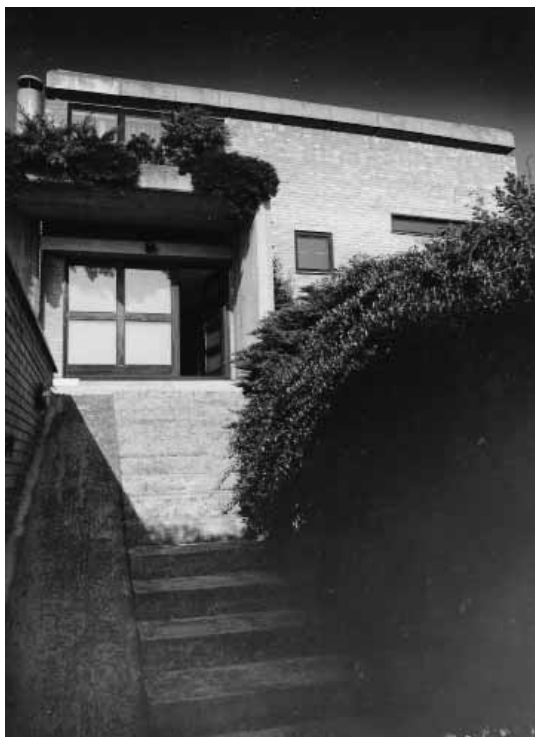
Rodinný dom architekta v Bratislave (Ivan Matušik, 1984). Nezmenená funkcia a permanentná údržba garantuje vysokú mieru autenticity a dobrý fyzický stav budovy
