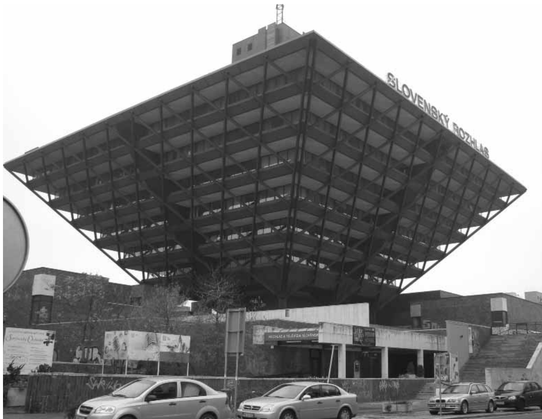
Foto Photo: Alexandra Rumanovská, 2012
