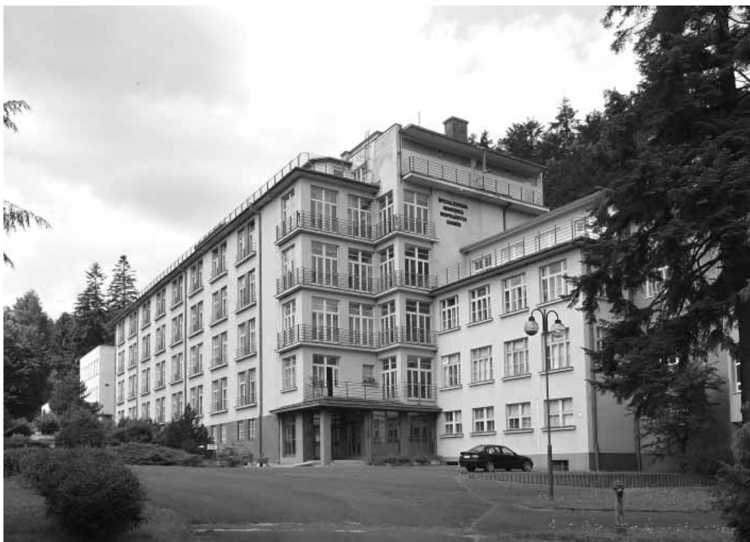
Kvetnica, pohľad na sanatórium z hlavnej prístupovej cesty
