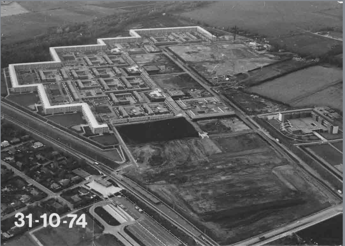
Avedøre Stationsby during construction Avedøre Stationsby počas výstavby
