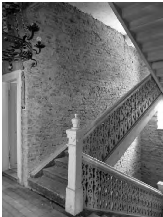
Pohľad do schodiskového priestoru na druhom podlaží vily Vecsey počas rekonštrukcie
