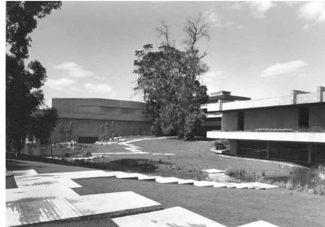
Calouste Gulbenkian Foundation exterior south perspective, 1969 Exteriér Nadácie Calouste Gulbenkian, pohľad z juhu, 1969
