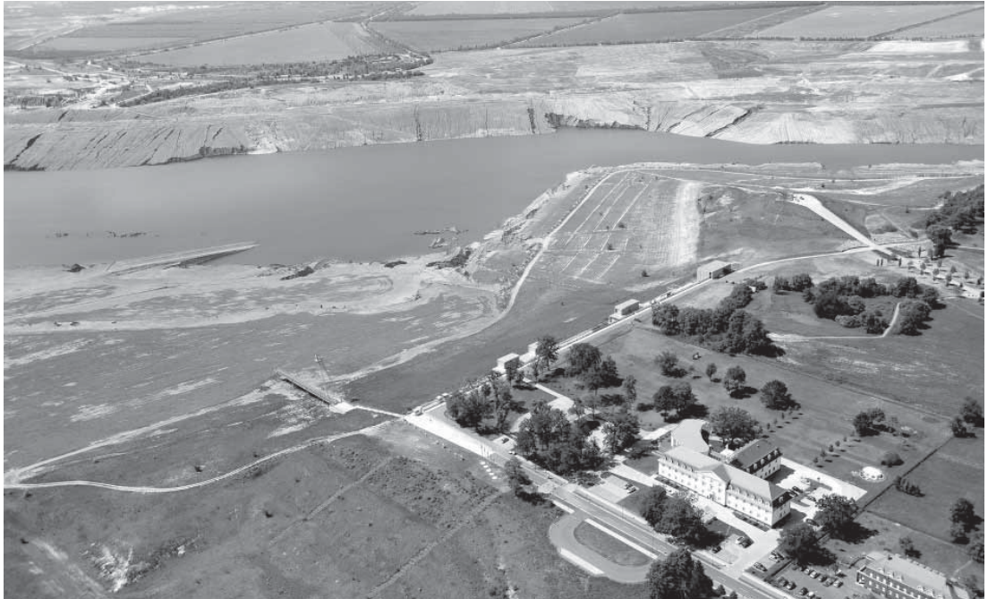
IBA Terraces by the future Großbräschen Lake IBA terasy budúceho jazera Großbräschen
