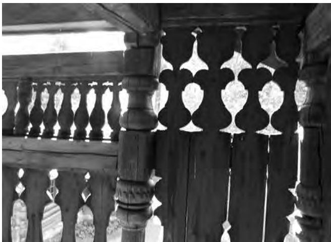
DÝCHAJÍCÍ STĚNA SÝPKY Z NES V HALLINGDALU Z OBDOBÍ 1700 – 1797, V SOUČASNÉ DOBĚ V OPEN AIR MUSEU V OSLU
